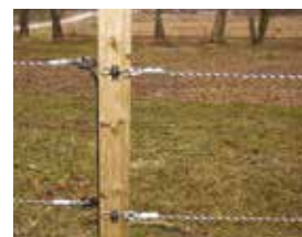
Bilde 7. Bandet kobles til grindisolatoren.
