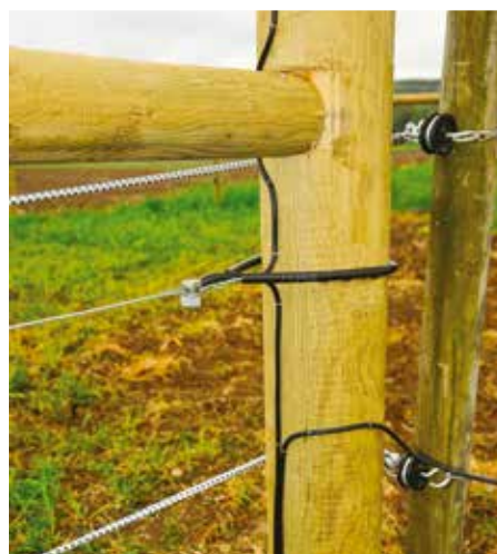
Bilde 22. Tråd kobles med strømkabel og trådsjøt.
