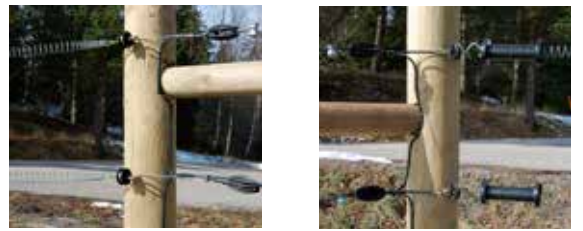
Bilde 16 og 17. Montering fjærgrind.
