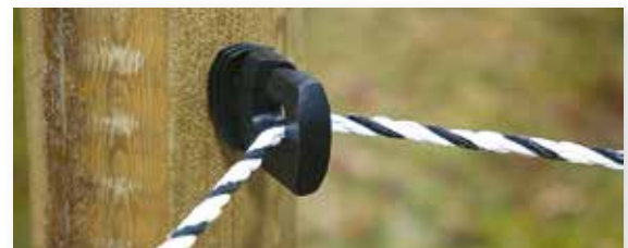
Bilde 2a. Isolatorene plasseres diagonalt på stolpen i hjørnet. Her for tråd/tau.
