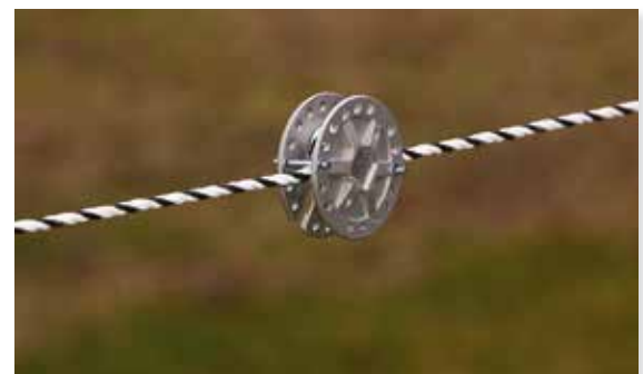
Bilde 9. Skjøt bandet med hjørneisolator og skjøteplate.
