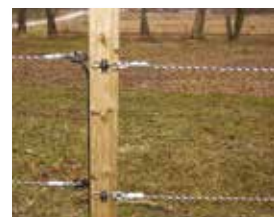
Bilde 7. Bandet kobles til grindisolatoren.
