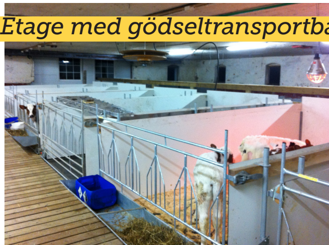
Gruppboxar installerade i etage på balkar. Gödseltransportband under trallen för ut gödseln.
