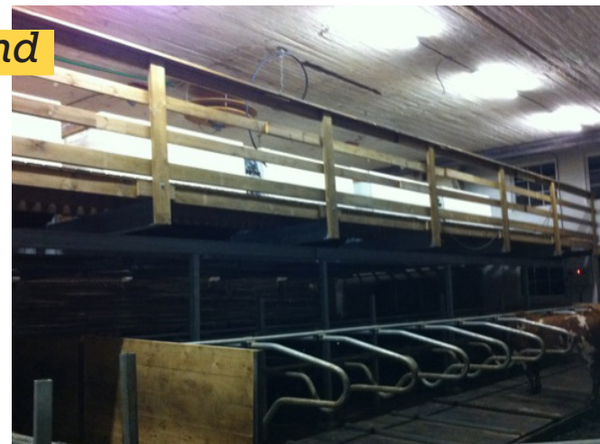
Gruppboxar installerade i etage på balkar. Gödseltransportband under trallen för ut gödseln.
